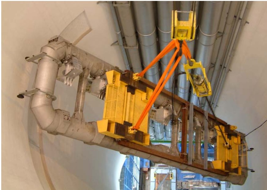
Descente d'une bobine de l'aimant toroidal dans la caverne d'ATLAS
