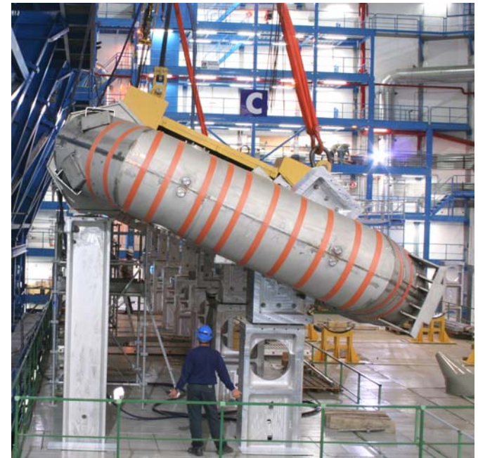
Mise en place sur la structure support Précision \pm 2 mm
