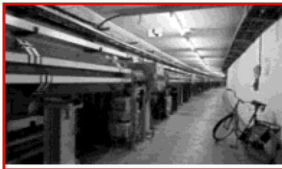
Tunnel de PETRA à Hambourg
