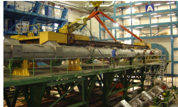
6 – Dépose de la bobine sur la plate forme
