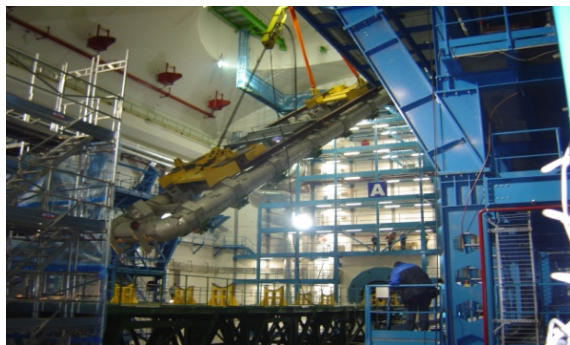
5 – Remise en position horizontale de la bobine
