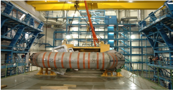
1 – Installation de l'outillage et accrochage au ponts
