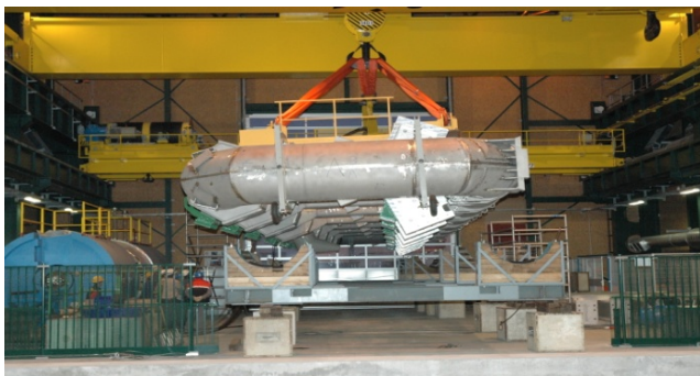
1 – Levage de la bobine et transport au dessus du puit
