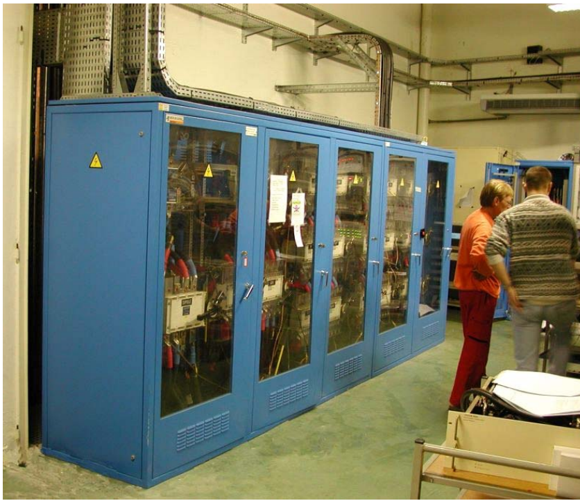
Figure 72 : Le 'switching board' : point de passage de toutes les alimentations de puissance à l'ESRF.
