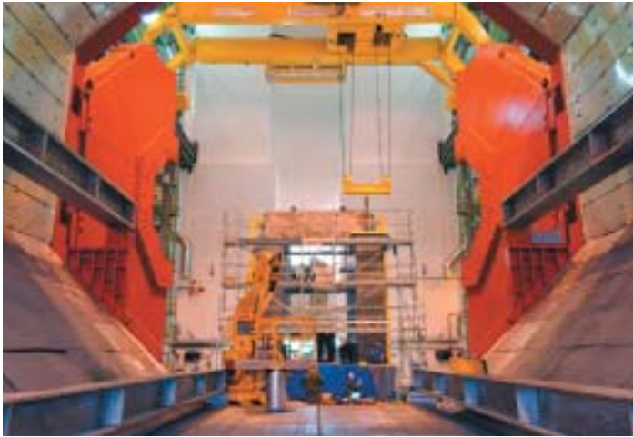
Assemblage de la culasse de l'aimant dipôle du spectromètre muons vu de l'intérieur de l'aimant solénoïdal de l'expérience Alice. © Cern
