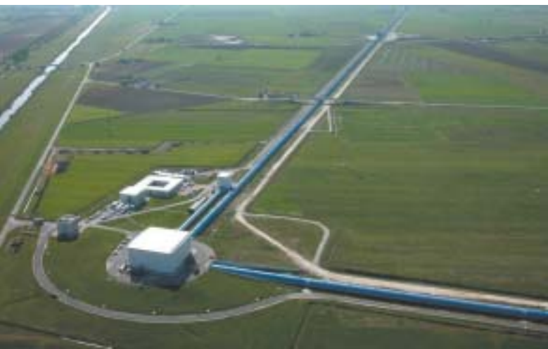
Vue aérienne de l'antenne de détection Virgo. © EGO – Virgo / CNRS Photothèque
