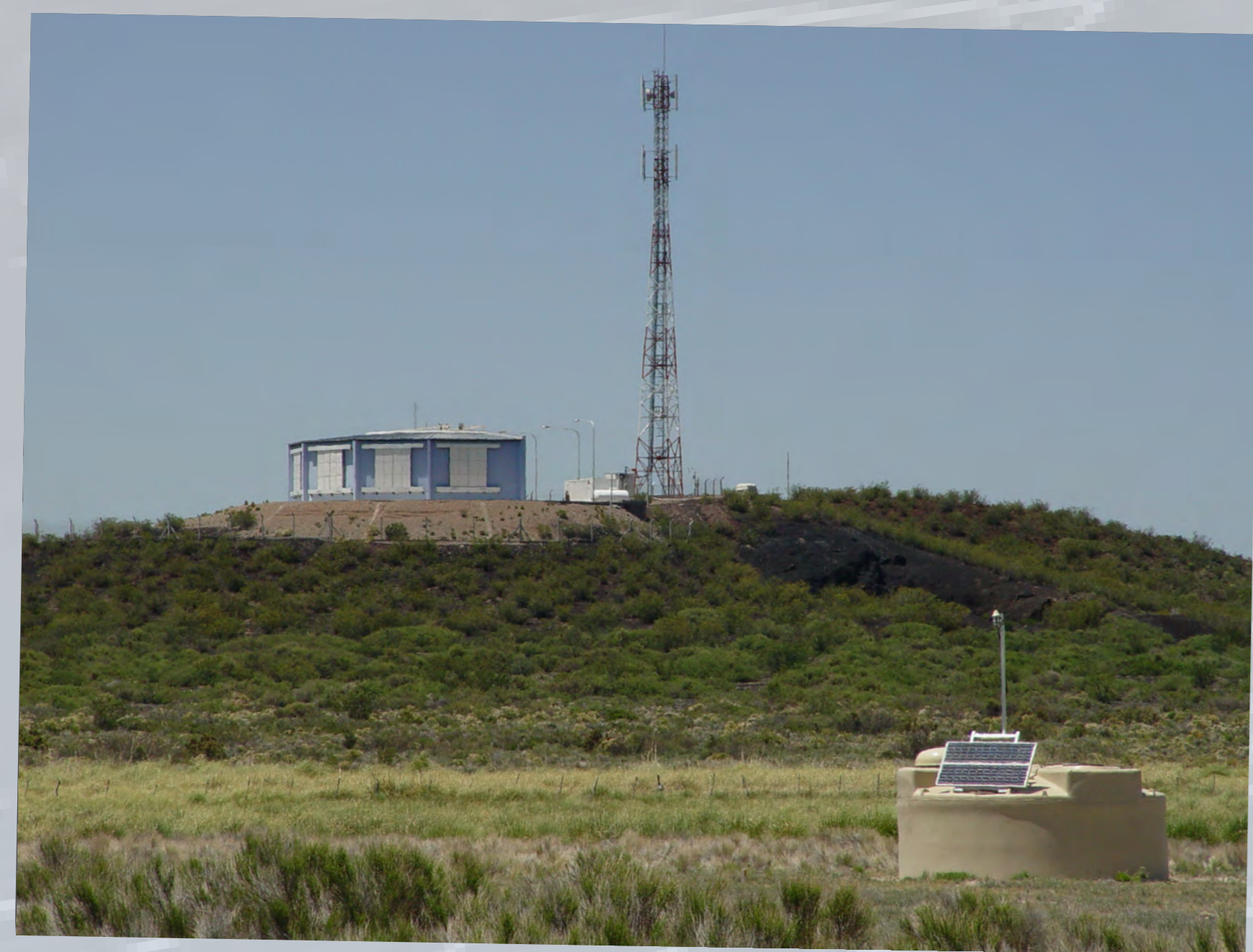
Observatoire Pierre Auger. Sur la colline : un des bâtiments abritant 6 des 27 télescopes de fluorescence. Au premier plan, un des 1660 détecteurs de particules © Observatoire Pierre Auger
